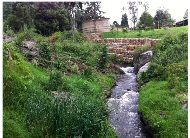
Foto 2: Quebrada El Asilo colinda con Club La Pradera
